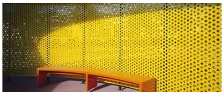
Perforerte plater rekkverk, svalganger og balkong
